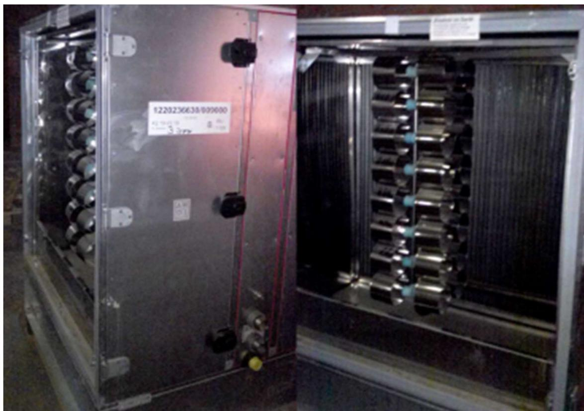
Более 70 форсуночных камер установлено с системах кондиционирования воздуха комплекса ВТБ Арена.
